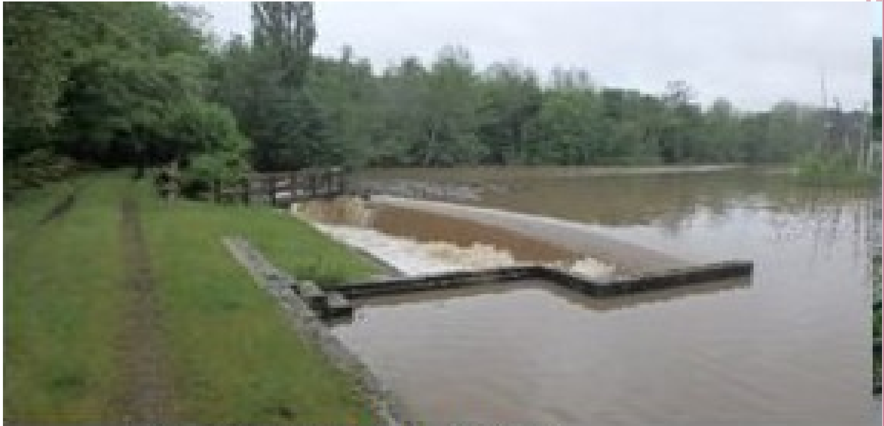
Déversement du bassin de Saint Forget
