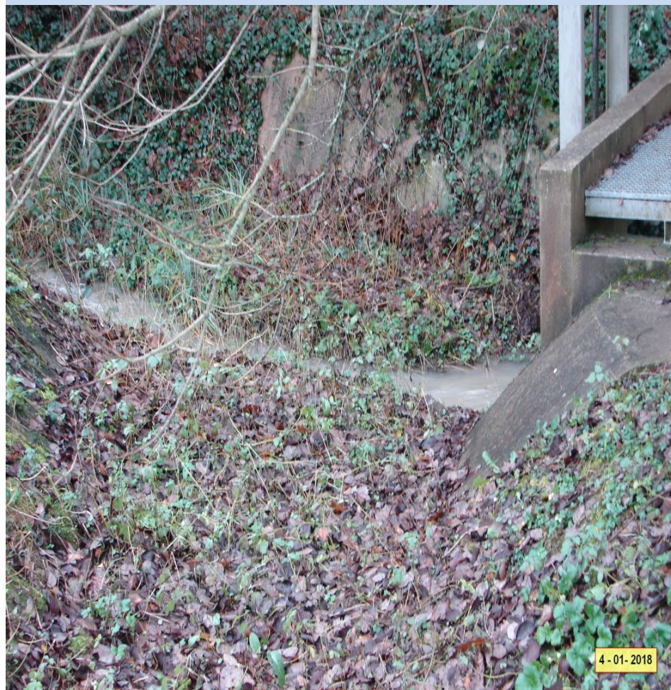
Vanne sur la Frileuse
