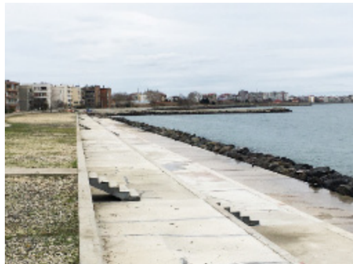
Digue côtière destinée à éviter l'inondation d'une zone résidentielle. La digue pourra être rehaussée à l'avenir si le danger d'inondation augmente (Bulgarie).
