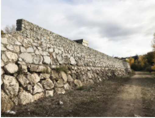
Mur surélevé de 200 mètres de long à la confluence de deux rivières où des inondations se sont produites par le passé (Espagne)
