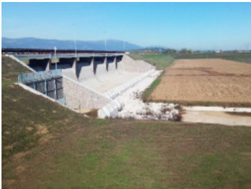
Réservoir vide utilisé pour le stockage temporaire d'eau afin de réduire les risques d'inondation des villes situées en aval. Les 110 hectares du réservoir sont également utilisés pour l'agriculture (Italie).
