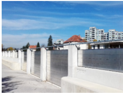
Digue fluviale dotée de parois amovibles permettant l'inondation contrôlée d'une rive afin de protéger la rive opposée, densément peuplée (Slovénie)
