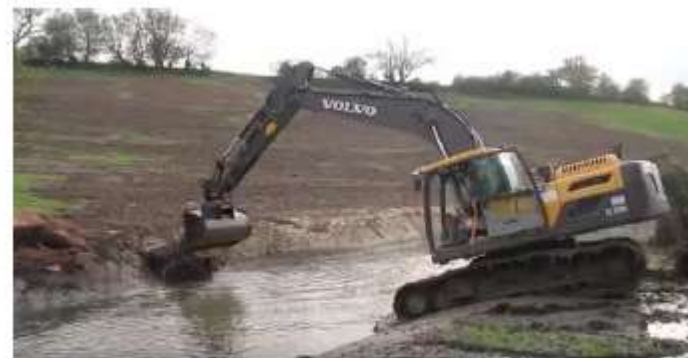
Mise en place d'une souche en berge
