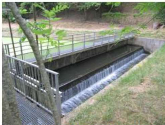
Le déversoir du décanteur (vue vers l'amont)
