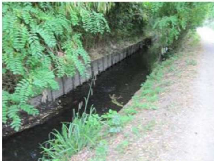
Protection en palplanche bois en rive gauche
