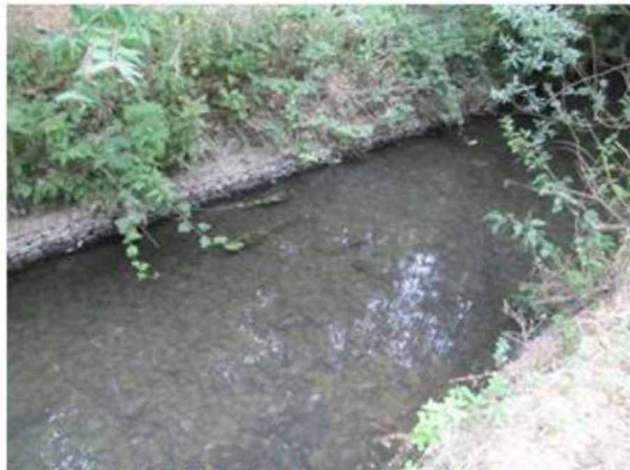
La Bièvre et ses berges en gabions
