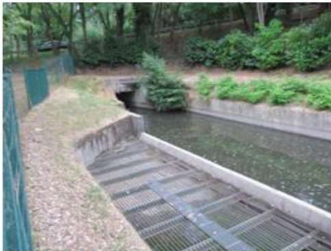
L'arrivée de la Bièvre dans le décanteur (vue vers l'amont)
