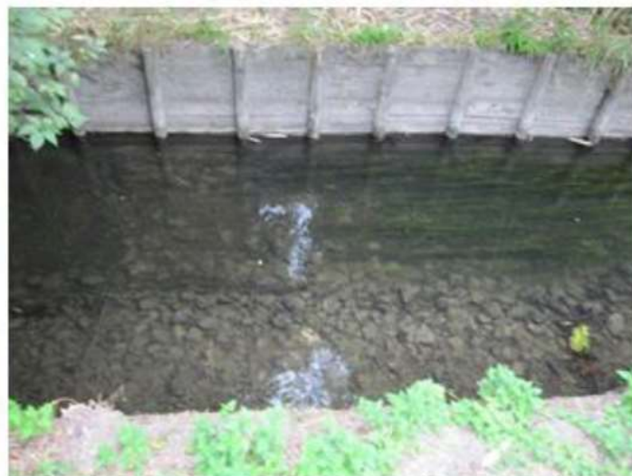
Fond du lit en gabions et tapis de végétation aquatique
