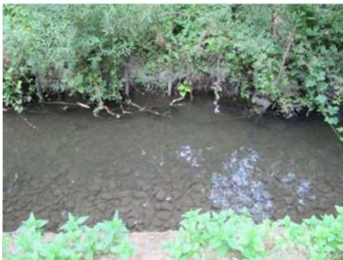
Pieux nus en rive gauche
