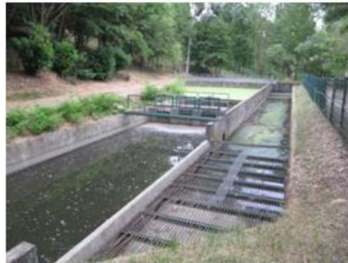
Le décanteur et son déversoir de crue (vue vers l'aval)
