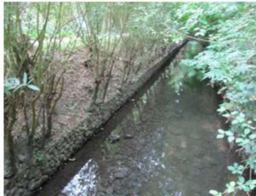
La Bièvre et ses berges en gabions (vue vers l'amont)
