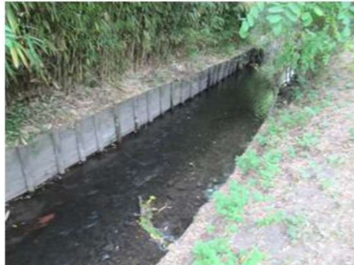
Haie de bambous (vue ver l'aval)
