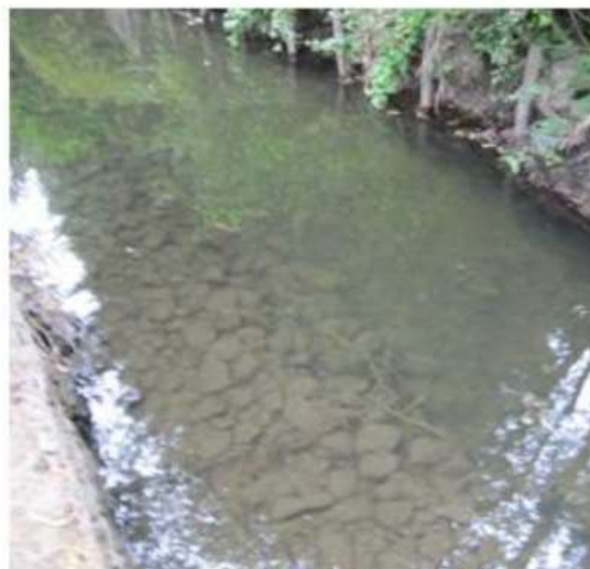
Fond du lit en gabions
