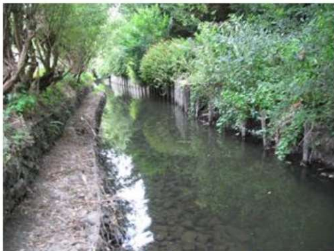
Gabions en rive gauche et pieux nus en rive droite (vue vers l'amont)
