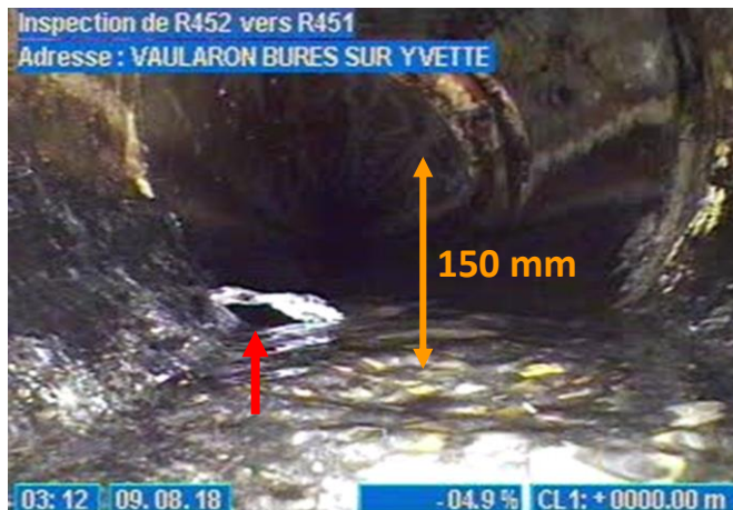
Infiltration dans le regard
