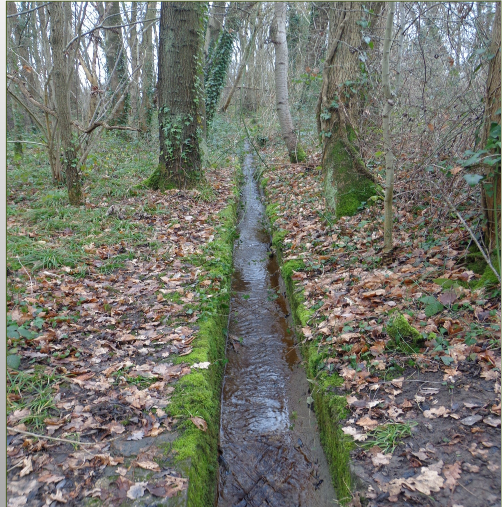
Canalisation par temps sec le long du viaduc. Photo P. Farret 22-01-2016
