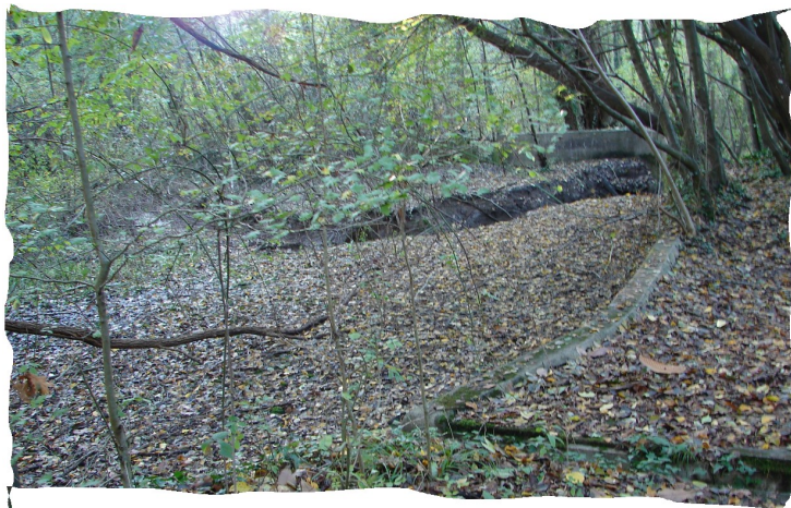
Envasement du Bassin du Baratage photo 2020 PF
