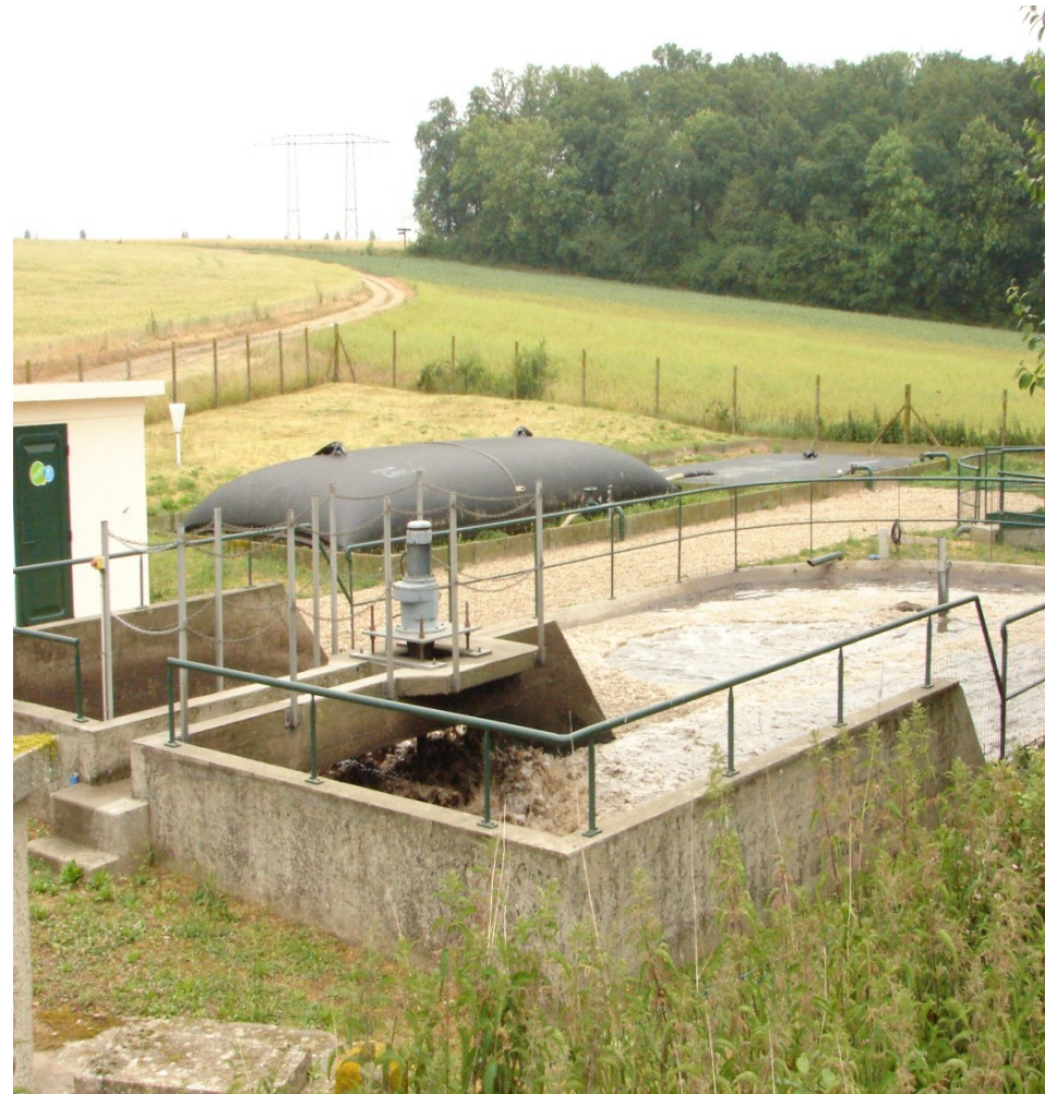
Station d'épuration de Gometz la Ville avant travaux 2011 P. Farret
