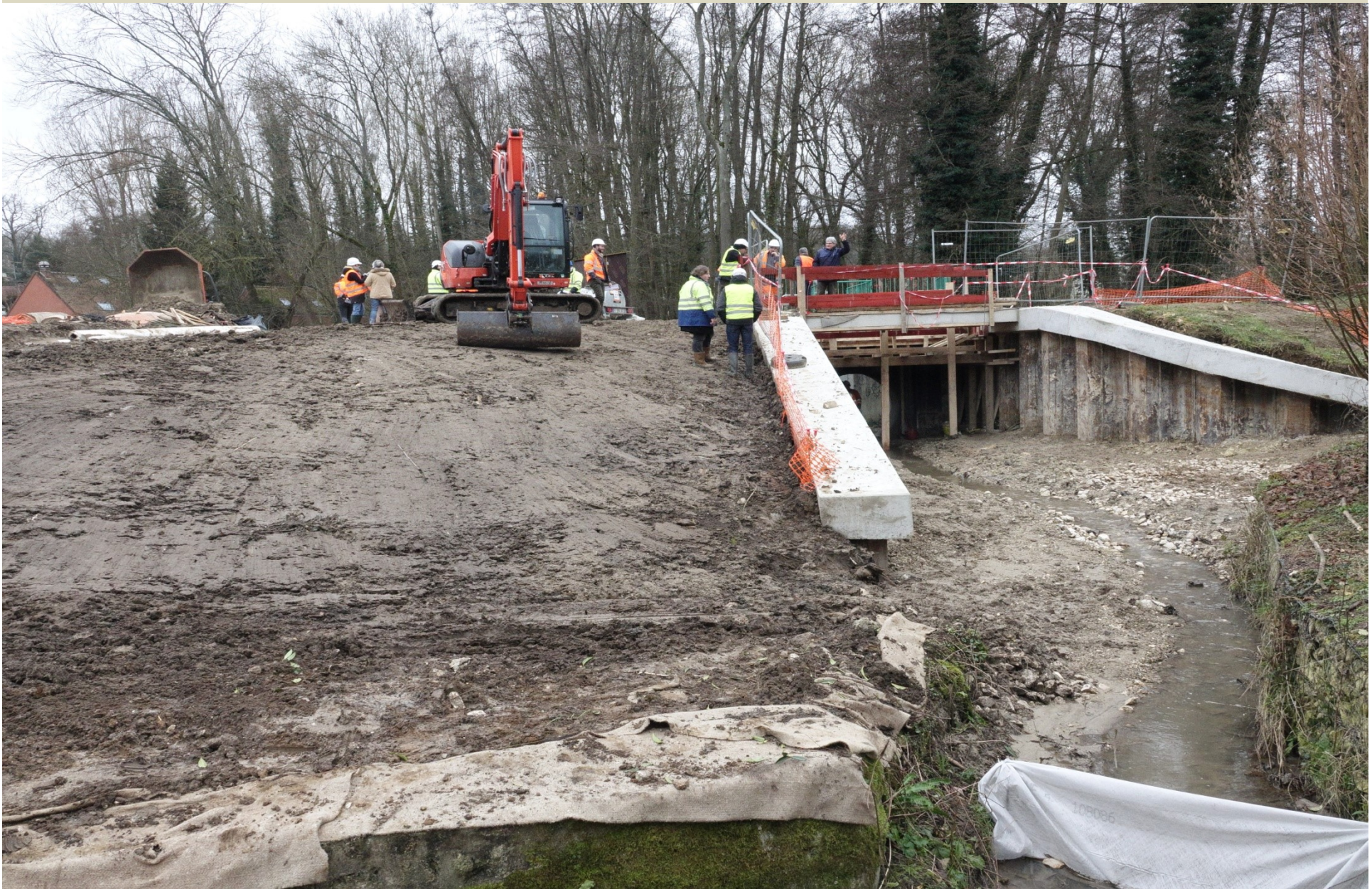
Visite de chantier 02-02-2023 Rue de la Promenade. Photo Pierre Farret
