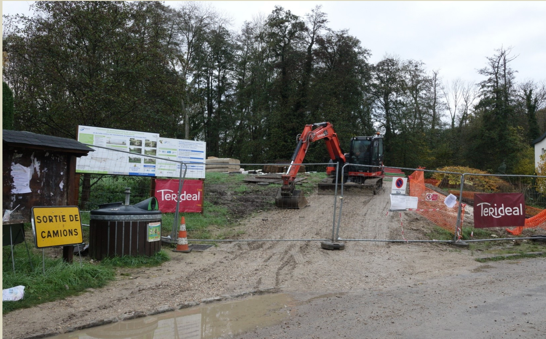
Visite de chantier 19-11-2022 ,Rue de la Promenade, Photo Pierre Farret
