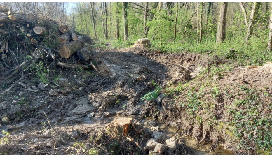
Gros travaux de terrassement/défrichage..
