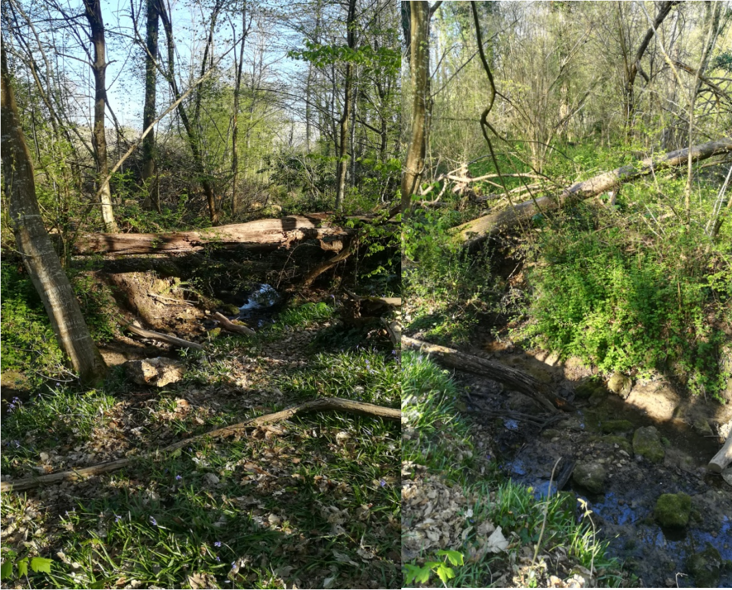
Importants et nécessaires travaux de déblaiement
