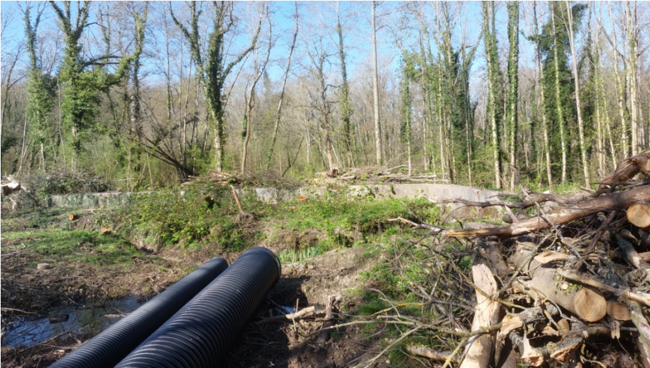
Le bassin avec vue sur les tuyaux (noter la taille) qui serviront à canaliser temporairement les eaux.
